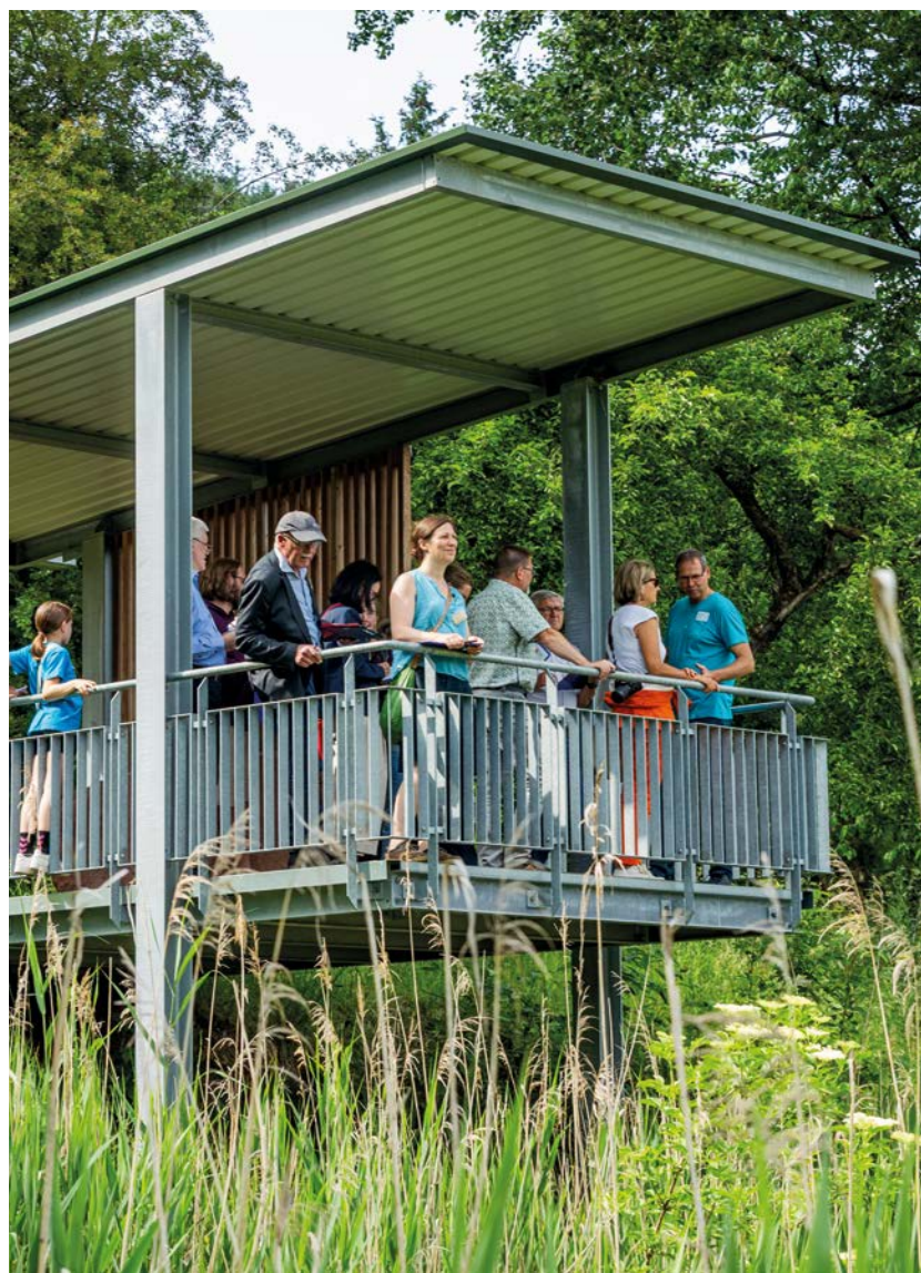
Radstation und Aussichtsplattform sind in zeitgemäßer Architektur und nachhaltig durch die Verwendung von Holz gestaltet
