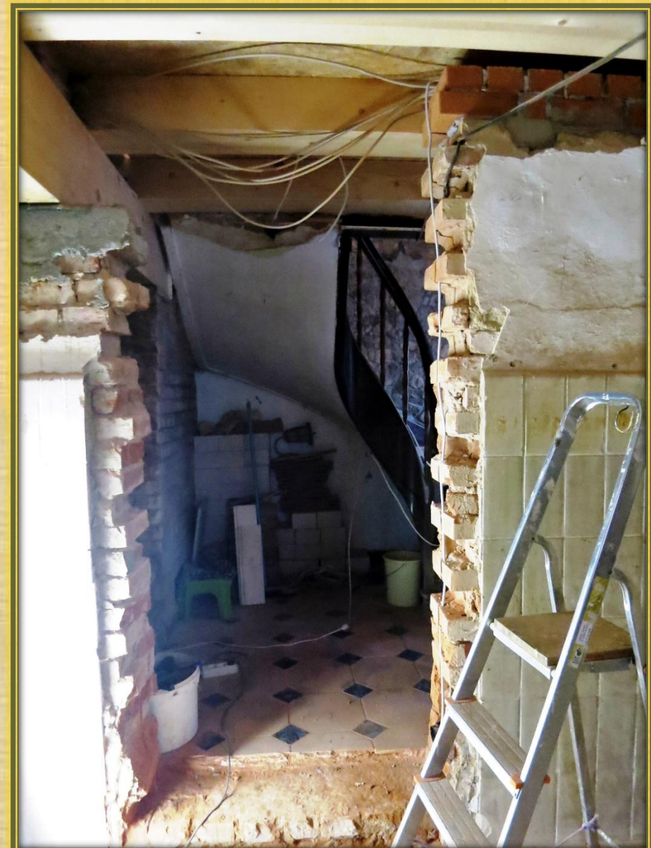
November 2017 Durchbruch Eingang - Milchammer
