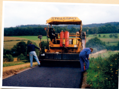
Feldwegebau von Bad Sodener Str. Ri. Weinberg
