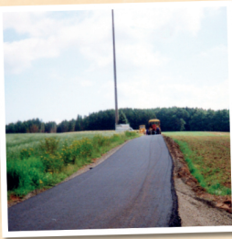
Feldwegebau zum Sendemast
