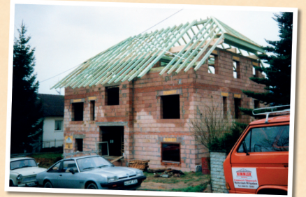
1995 Rohbau Bad Sodener Straße 5, Jürgen Werth
