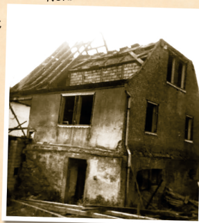
Rohbau Aufenauer 8, Wilhelm Werth
