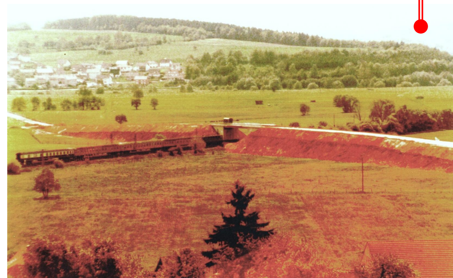
Ca. 1981 Bau der Bahnüberführung
