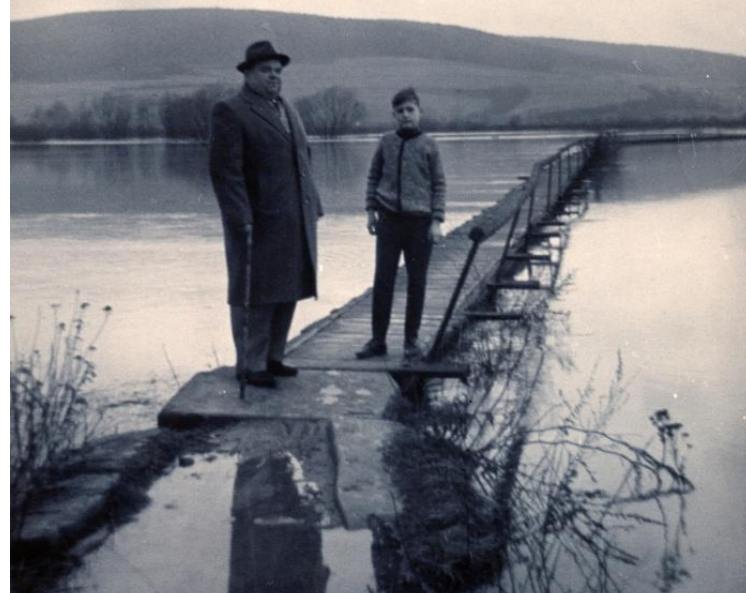
Beginn des Bohlensteg bei Aufenau
